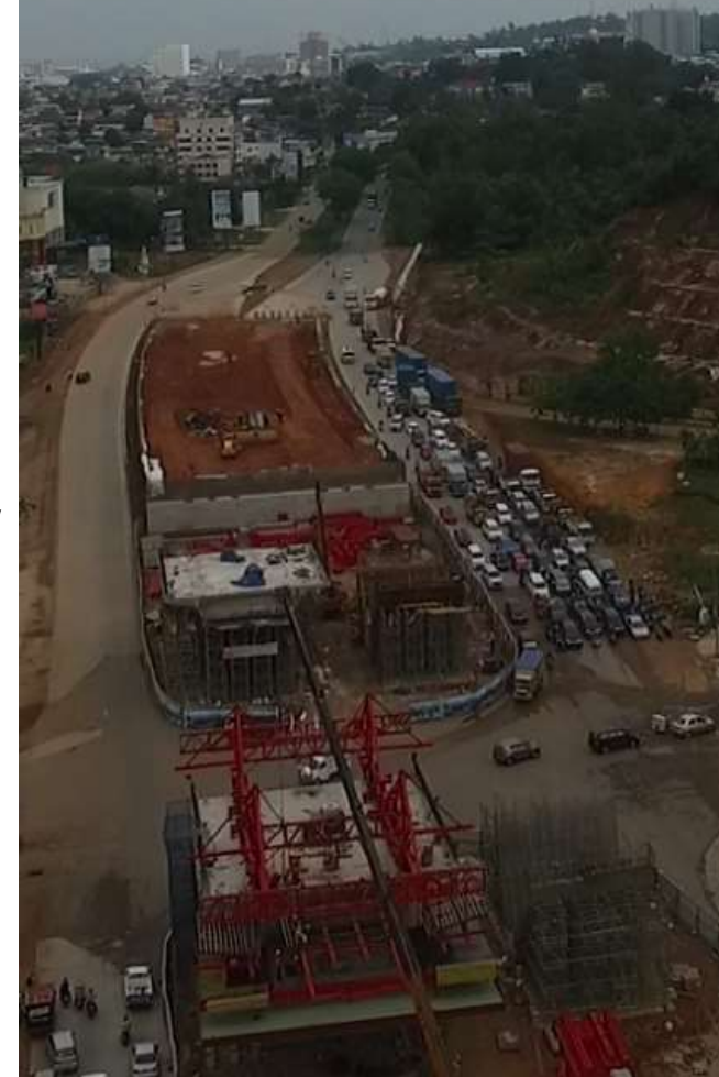
Progres pembangunan Fly over Simpang Jam
